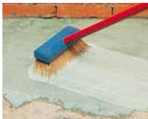
Planicrete -tel kevert cementkötésű tapadóhíd felhordása
