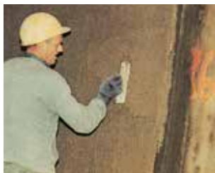
Cementkötésű vakolat Planicrete -tel. Építéshelyszín: Vile Marie autópálya alagút - Montreal, Kanada
