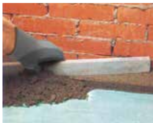
Planicrete -tel kevert cementkötésű kötött esztrich készítése
