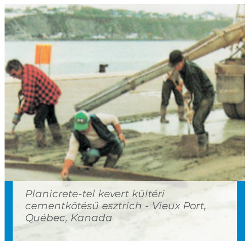
Padlójavítás: besimítás
