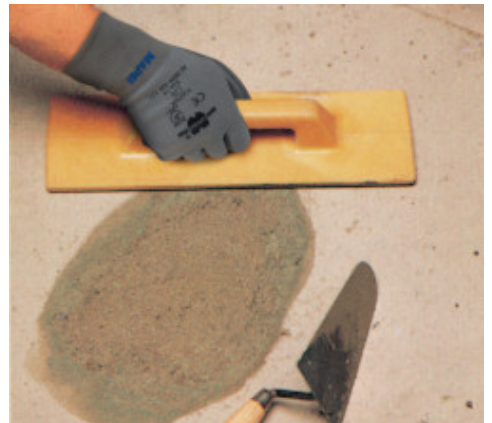
Padlójavítás: besimítás
