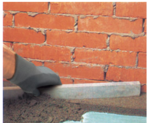
Planicrete-tel készített cementkötésű esztrich felhordása
